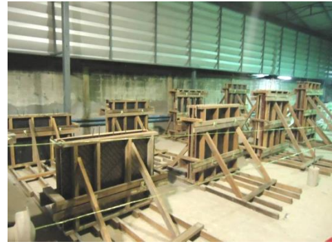
รูปที่ 1 : การเตรียมแบบหล่อไม้สำหรับผนังดินซีเมนต์บดอัด
